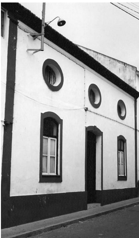
Casa de taipa, rebocada e pintada, em Rua Sarmento de Beires, Vila Nova de Milfontes (já demolida).
