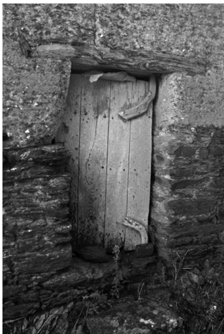
Pedra, terra e madeira. Parede em Montalto, Santa Clara-a-Velha.
